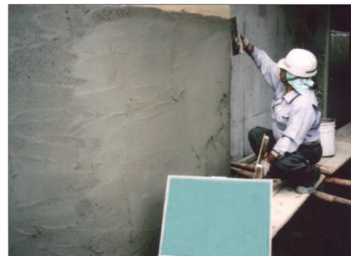
厚付け仕上用ポリマーセメントモルタル施工状況
