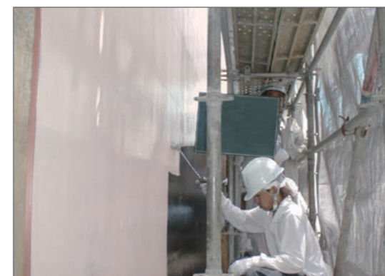
プライマー施工状況
